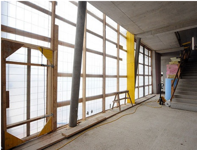
Der Rohbau für den Konzertsaal ist abgeschlossen
